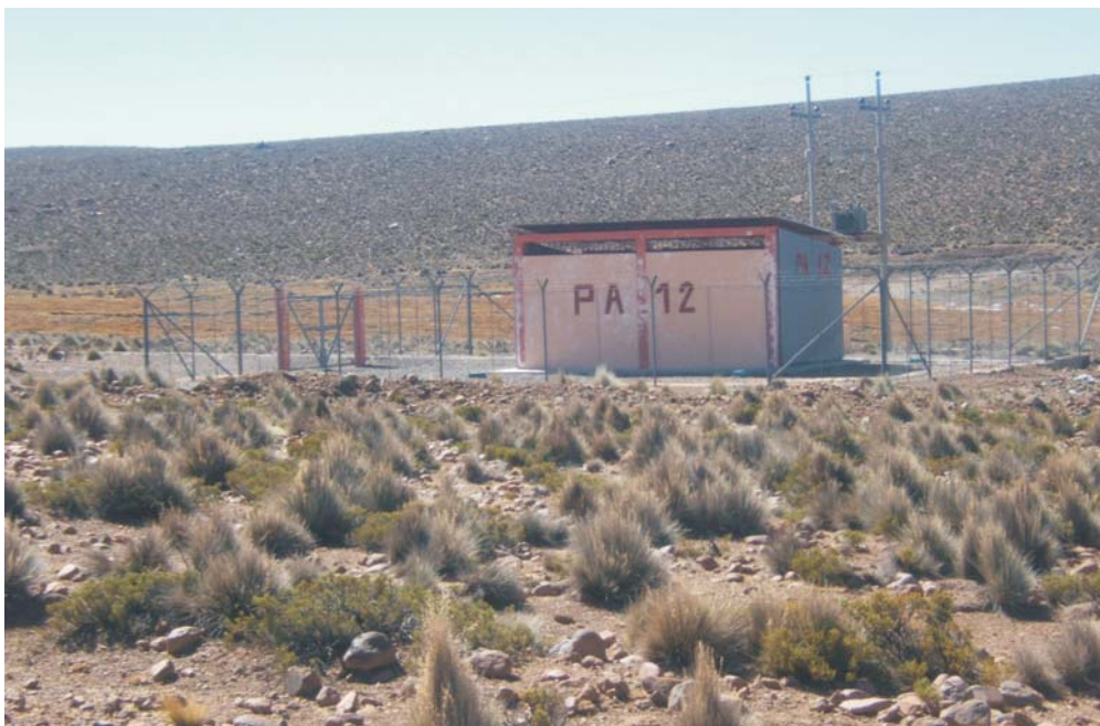
Foto 3.26 Captación de aguas subterráneas en el sector El Ayro mediante sondeos verticales.
