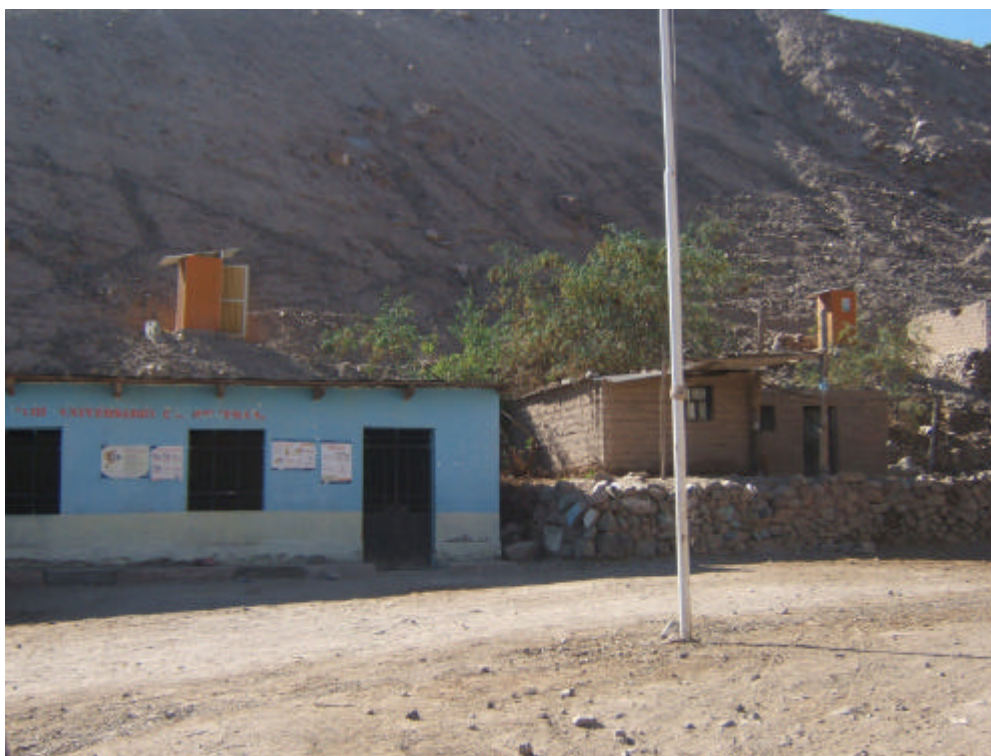
Foto 3.28 Letrinas en el sector Higuera, sin ningún tipo de impermeabilización en la base y causantes de contaminación de las aguas subterráneas.
