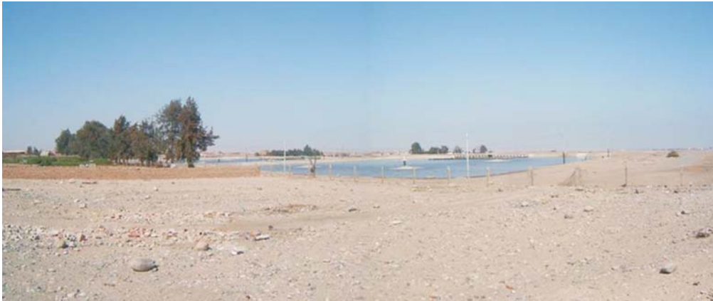
Foto 3.29 Planta de tratamiento de aguas servidas en el distrito de Gregorio Albarracín.
